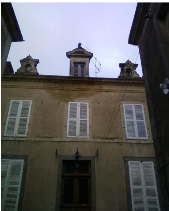
Vue avant restauration de la façade et des lucarnes.
