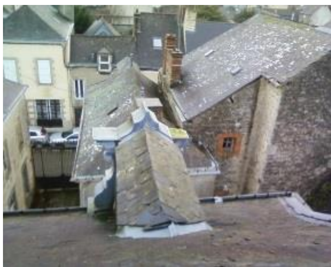
Vue la lucarne œil de bœuf avant restauration.
