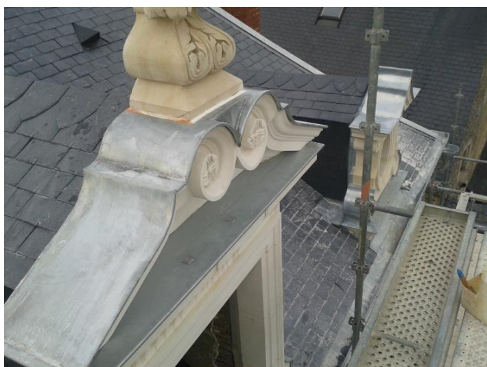
Habillage des frontons de la grande lucarne.
