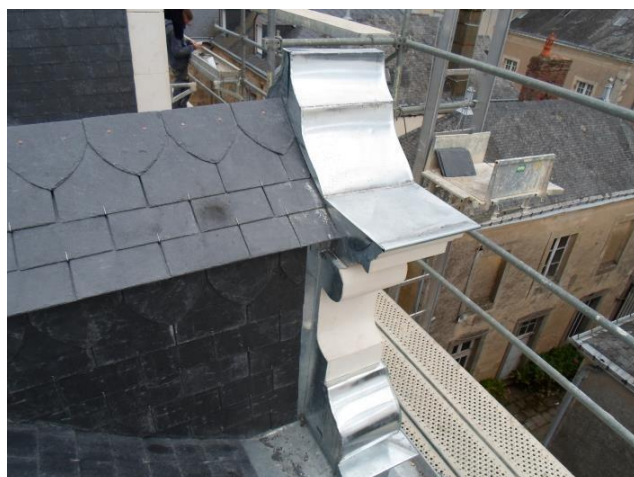
Vue arrière de l'habillage zinc de la lucarne avec œil de bœuf après restauration.
