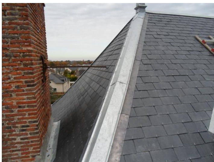
Arêtier zinc à ourlet et bande filet de plomb.
