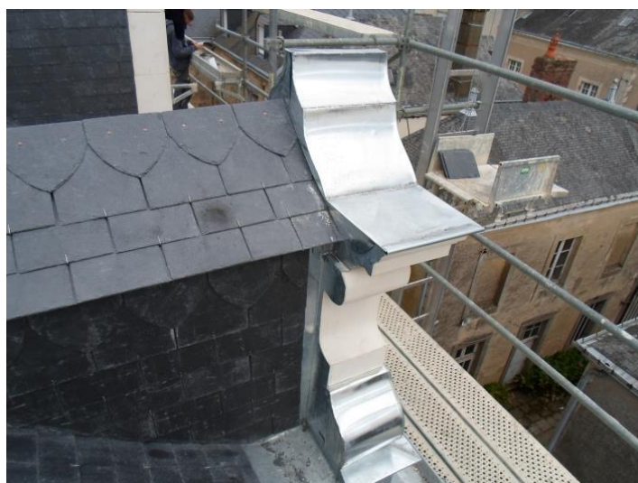
Vue arrière de l'habillage zinc de la lucarne avec œil de bœuf.
