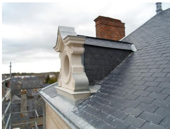
Vue après travaux.
